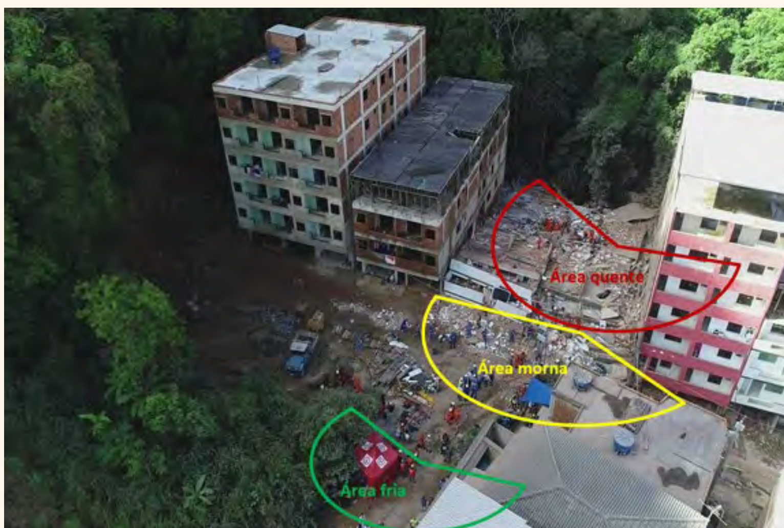
Comunidade da Muzema – Desabamento de dois prédios em abril de 2019
